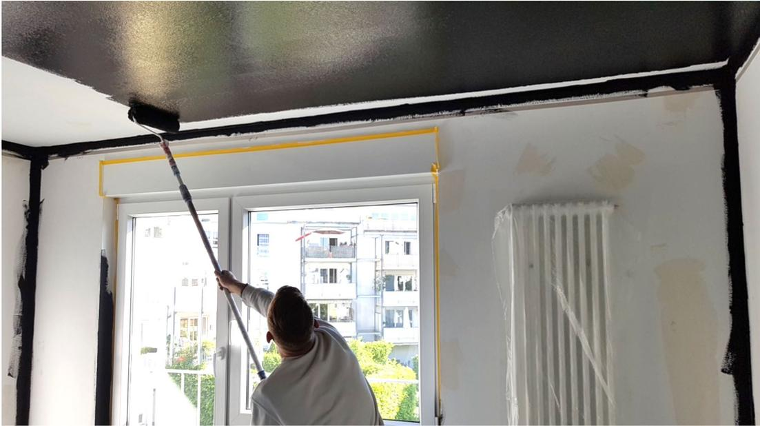
Abb. 09: ***Raumabschirmung mittels Abschirmfarbe***
