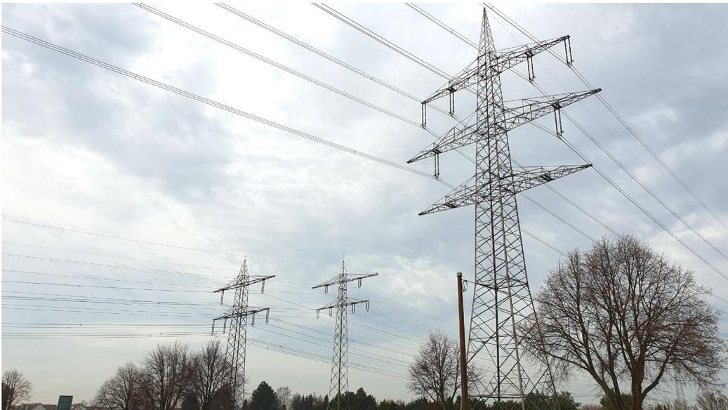
Abb. 10: **110 kV, 220 kV und 380 kV-Hochspannungsleitungen**
