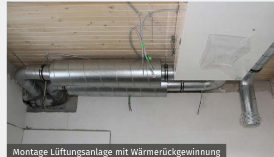
Montage Lüftungsanlage mit Wärmerückgewinnung
