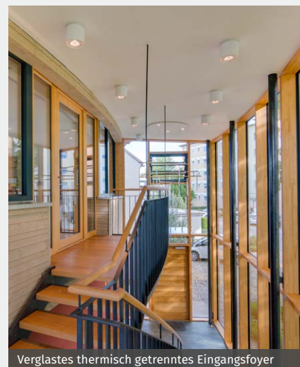
Verglastes thermisch getrenntes Eingangsfoyer
