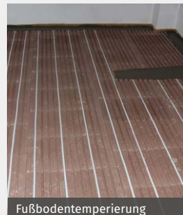
Fußbodentemperierung
