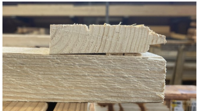
Abb. 26: Hinterlegen der Befestigungslatte
