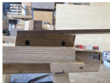
Abb. 18: Seitenansicht der ersten Schindelreihe auf dem Unterkonstruktionsrahmen
