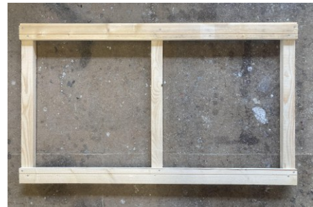
Abb. 15: Rahmenunterkonstruktion
