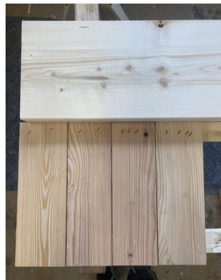
Abb. 20: Befestigung der Lärchenschindeln an der Konterlatte
