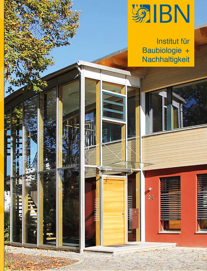
Stand 8/2021 Titel: Das Gebäude des Institut für Baubiologie + Nachhaltigkeit (IBN) in Rosenheim
