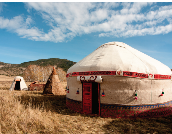
Abb. 03: Traditionelle mongolische Kazakh Jurte aus auseinanderziehbaren Holz-Wandgittern, mehreren Lagen Wollfilz und Baumwolltüchern
