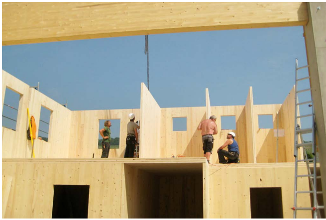
▲ Standardisierte VOC-Messungen in Massivholzhäusern mit Brettdübel- oder Brettsperrholzelementen in Fichte und/oder Tanne bieten in der Praxis- und Feldforschung wichtige Erkenntnisse über Abklingraten der kleber- und holzartspezifischen Emissionen und sind deshalb unverzichtbar für rechtssichere und vergleichbare Ergebnisse.
