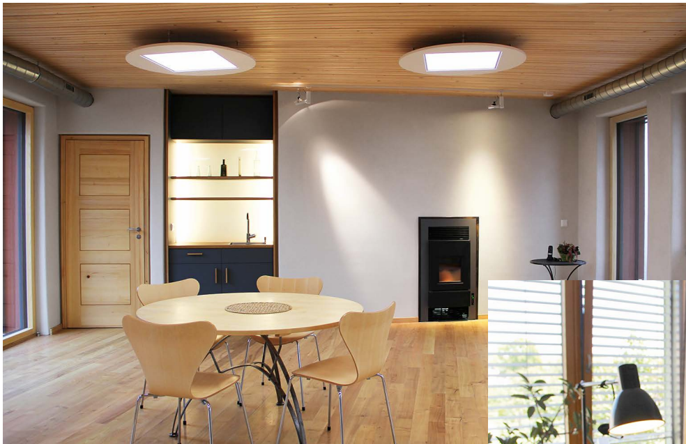
▲ Ausstellungs- und Vortragsraum des IBN: In Abhängigkeit vom Außenlicht in der Beleuchtungsstärke und Farbwiedergabe variables und flimmerfreies Deckenlicht sowie Akzentsetzung durch Strahler an den Wänden
