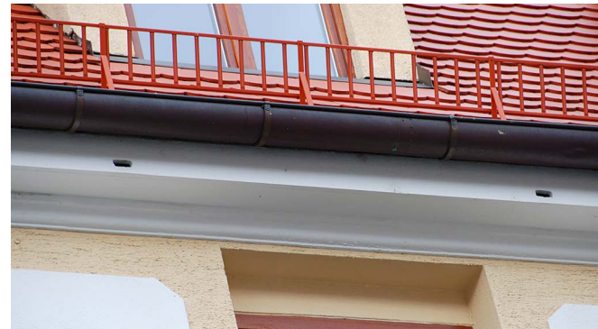
▲ Nistkästen für Mauersegler – offen und integriert in einem Traufkasten
