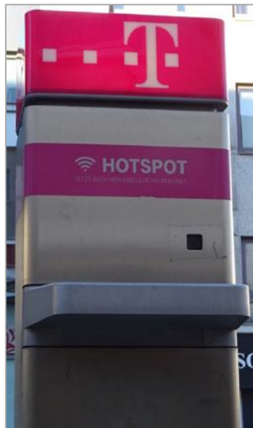
Abb. 1: Konventionelle Mikrozelle der Telekom mit LTE-Mobilfunk (Hotspot, Frequenzbereich 2600 MHz) in einer Fußgängerzone
