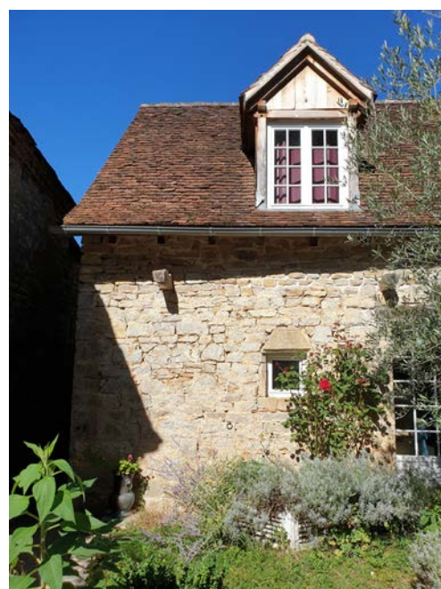
(4) Reparatur von Strohlehmgefachen. Intakte Teile werden erhalten und die Fehlstellen mit wiederaufbereitetem Material ergänzt (5) Steinmauerwerk mit Lehmmörtel in der Dordogne
